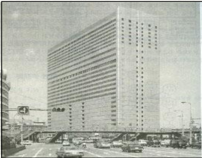
개방형의 백화점(다이마루 백화점)
